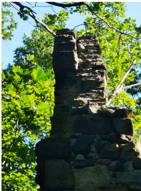
Fot. 4. Uszkodzony „koci bieg” i spływ wewnętrznej strony ściany szczytowej.
