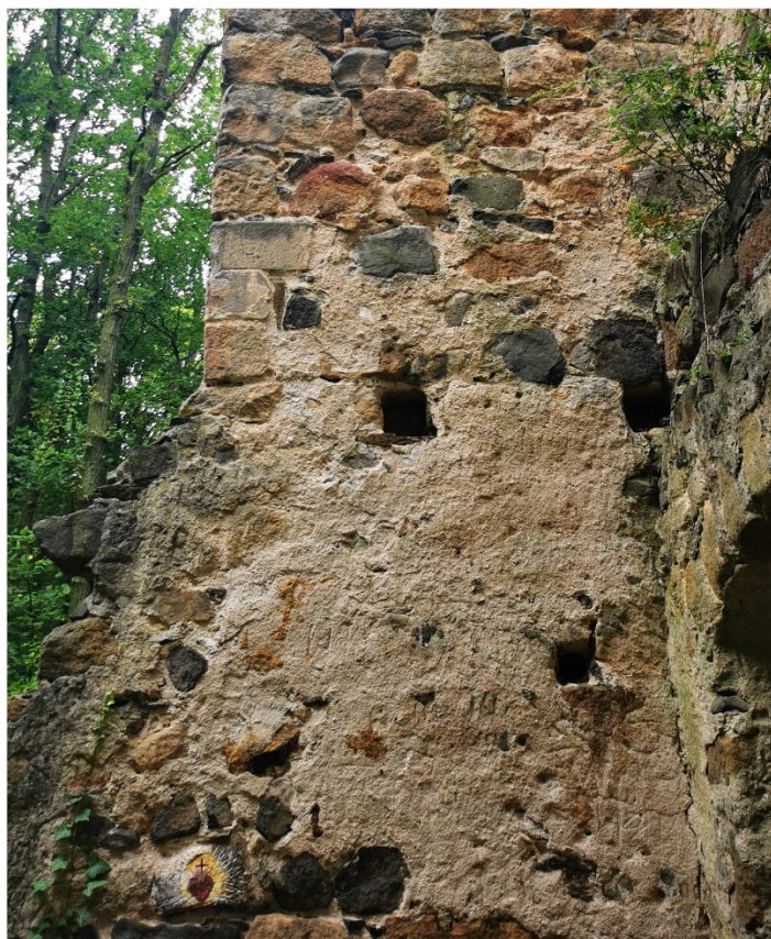
Fot. 2. Zachowany tynk wewnętrzny na ścianie południowej.
